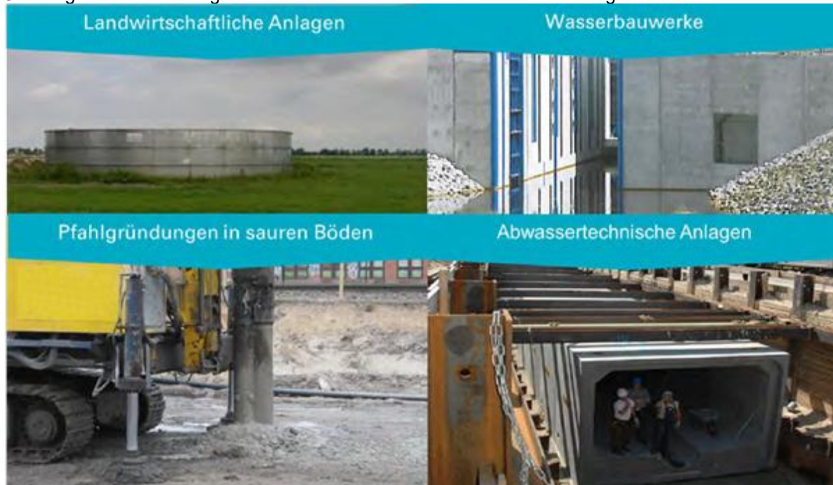
Abbildung 1 Anwendungsbereiche – Säurewiderstandsfähigkeit von Betonen
