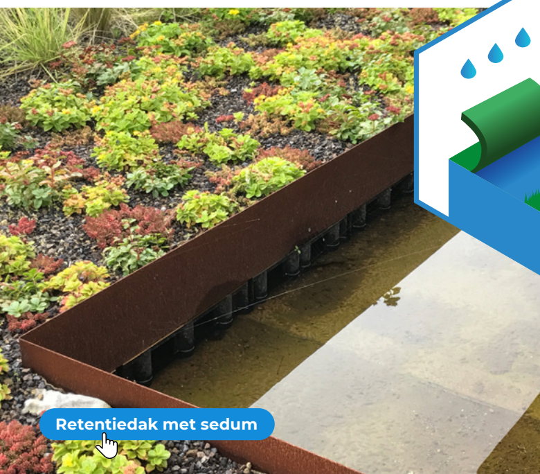
Retentiedak met loop-/terrasverharding
